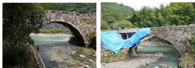
写真-1 二俣渡橋(上流側) 写真-2 二俣福良渡橋(下流側)
