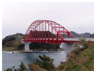
図-1 樺島大橋外観
