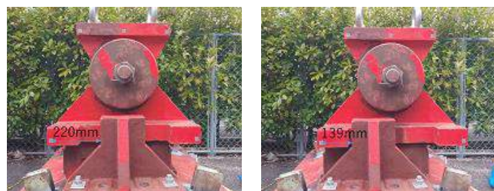
図-7 支承変位（左：水平変位なし、右：最大水平変位発生時）
