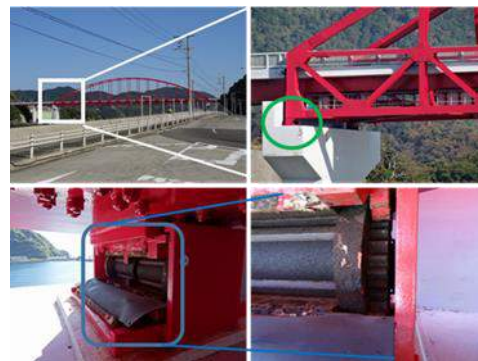
図-1 橋梁支承の状況（樺島大橋）
