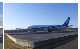
写真 3 空港内の誘導路橋
