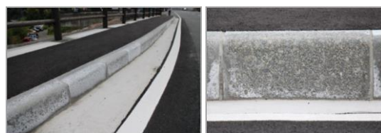
図1 GPブロックの表層劣化の例
