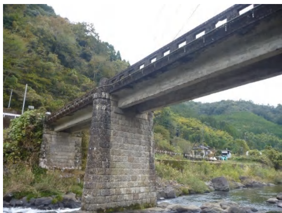
写真 1 おかくら橋の外観
