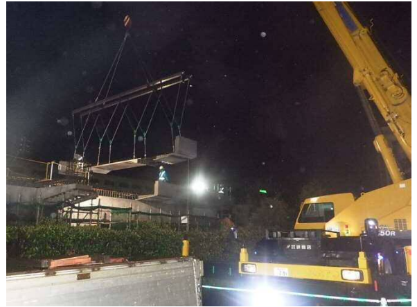
図-4 架設時写真
