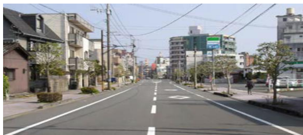
図-3 比較的交通量の多い片側1車線の道路
