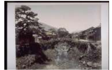
写真 2 桃溪橋の古写真
