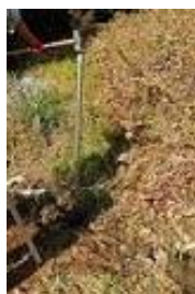
写真-1 センサ設置の様子
