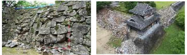
写真-1 石垣の孕み出しの様子 写真-2 石垣の崩壊の様子
