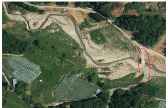
図-2 佐田川合流地点から 7.0km 地点（復旧後）
