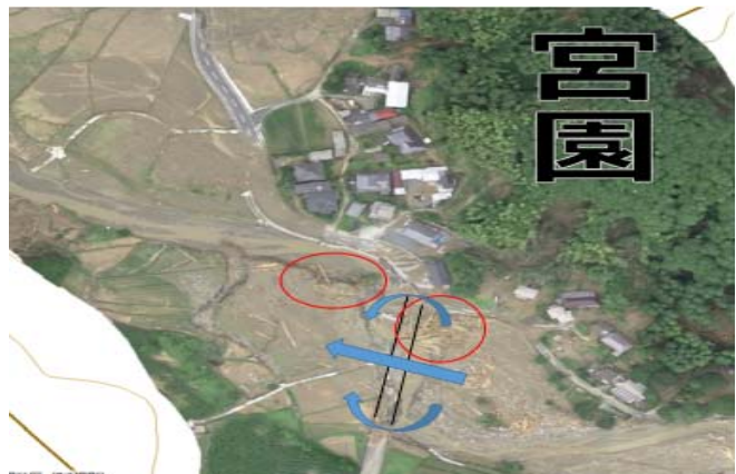
図-5 佐田川合流地点から 6.0km 地点(災害時)
