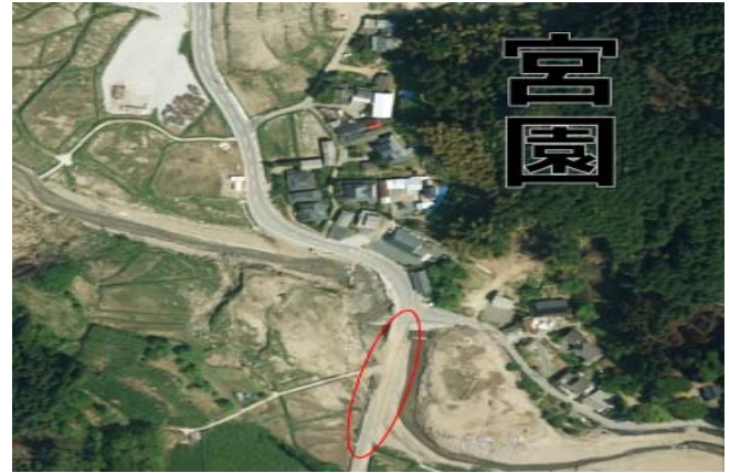
図-4 佐田川合流地点から 6.0km 地点(復旧後)
