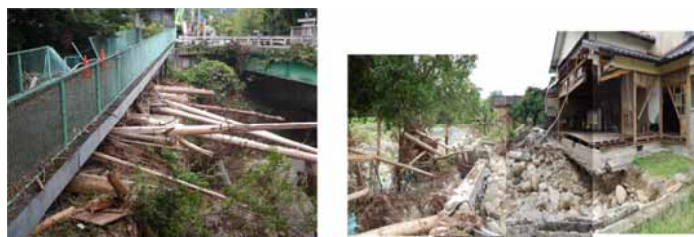
写真-2 流木被害の様子
