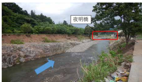
写真-1 夜明橋周辺の被害状況
