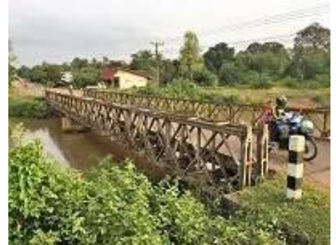
写真1 ベイリー橋の例（ラオス）
