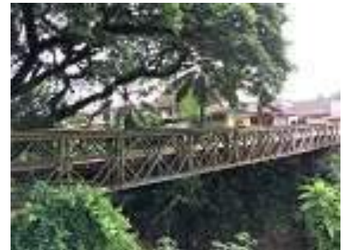
写真 5 Namphanai River Bridge
