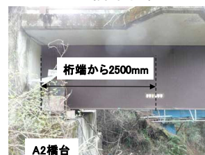
写真-1 山間部橋梁 試験片配置位置
