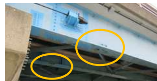
写真-2 沿岸部橋梁 試験片配置位置
