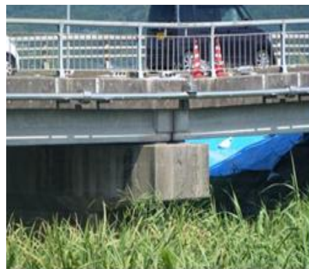
写真-1 中間橋脚の沈下現象
