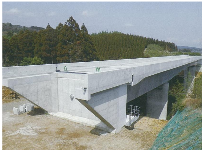
写真-1 橋台のウィング壁
