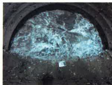
図1 画像処理前のトンネル切羽画像
