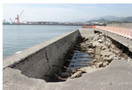
写真-1 中詰土砂の流出とエプロンの陥没
