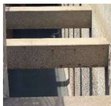
写真-1 放水路の梁部の写真
