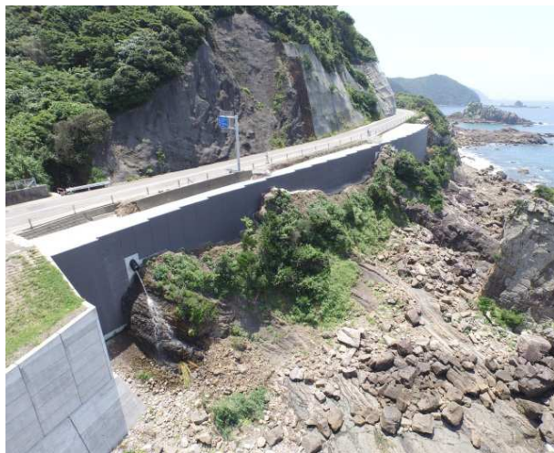
写真-2 調査箇所②施工完了状況
