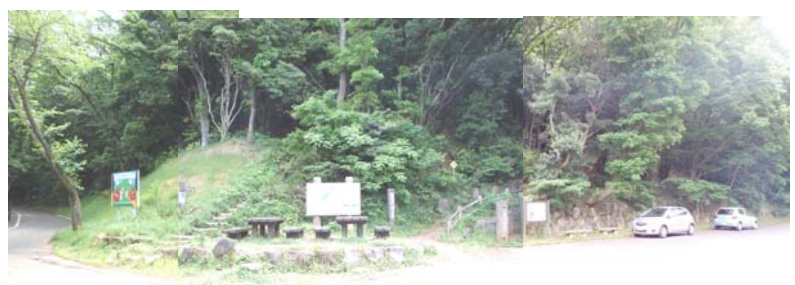
写真-1 対象斜面遠景（小倉北区足立公園内）
