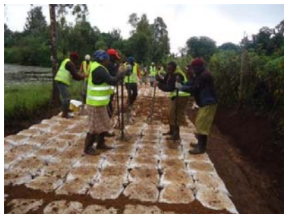
写真 3 土のうを用いた路盤工
