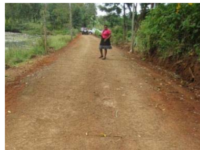
写真 4 写真 1 の箇所の、土のう工法による施工後の様子
