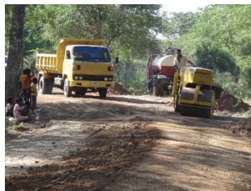
写真 2 LBT による農道施工状況
