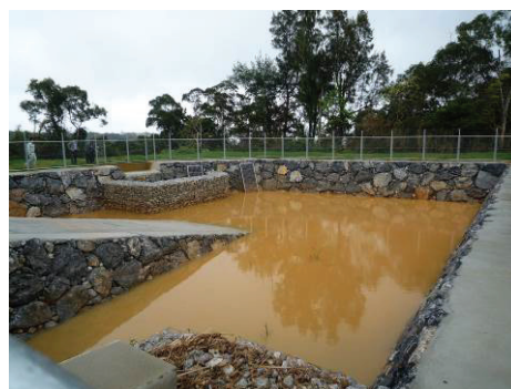
写真-1 沖縄県における農業用沈砂池の 1 例 (2017 年 3 月 11 日撮影)
