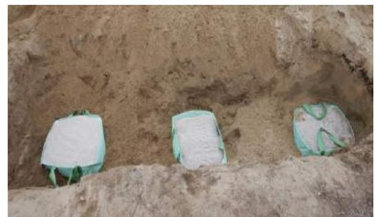
写真2:地盤内にゆるみ部を設置
