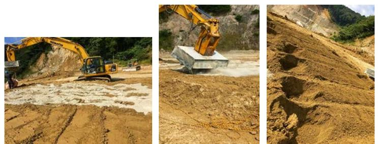
(a)固化材散布 (b)改良の様子 (c)改良後
