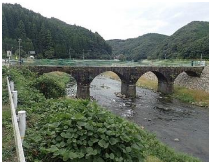
写真-1 宮ヶ原橋全景（2017 年 10 月撮影）
