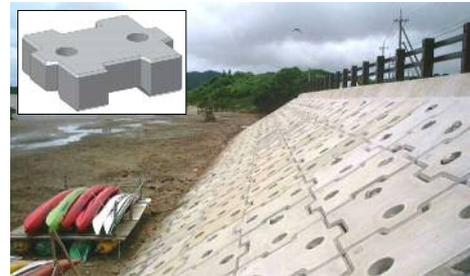
図-1 有孔平型被覆ブロックと使用例
