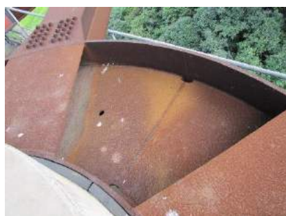
(a) 橋脚上の支承部上部
