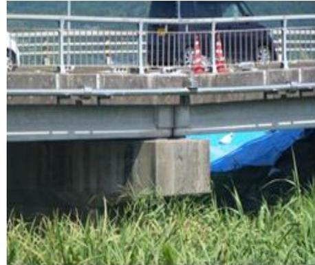
写真-1 中間橋脚の沈下現象
