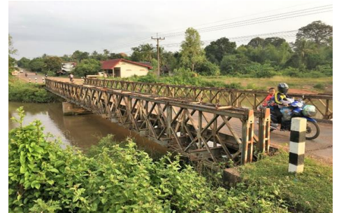
写真1 ベイリー橋の例 (ラオス)
