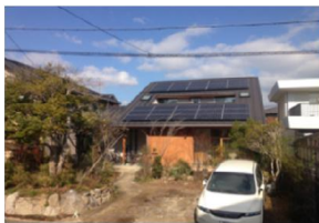
図1 雨水利用実験住宅
