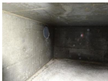
写真2. コンクリート製タンク
