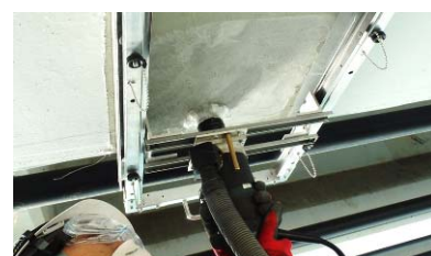
写真-4 表面研磨装置による研磨状況
