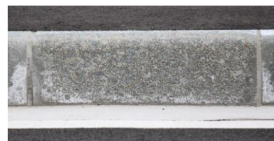
図1 GP ブロックの表層劣化の例
