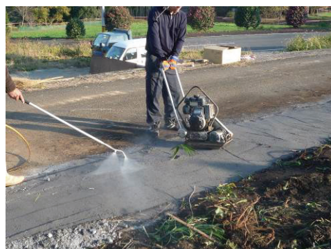
写真-1 試験施工の状況（2015年12月1日撮影）
