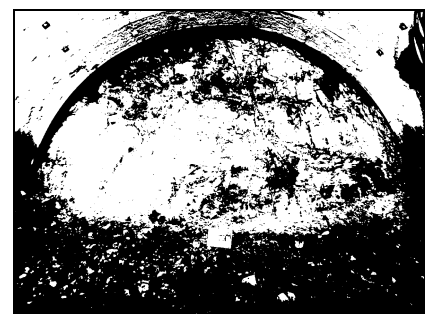
図3 画像処理後のトンネル切羽画像
