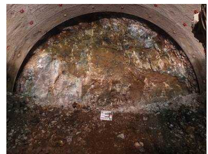
図2 画像処理前のトンネル切羽画像
