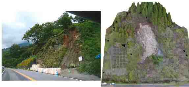
写真-2 左: 断層B上の斜面崩壊(崩壊B)
