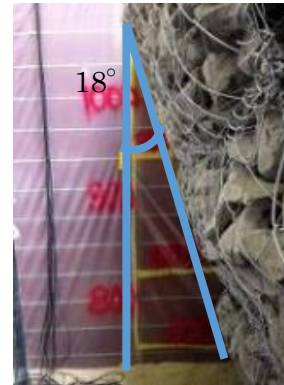
写真-2 実験後の蛇籠の傾き
