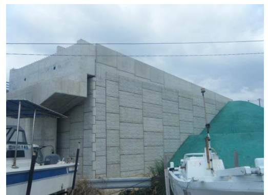
写真 - 3 補強土壁の完成状況
