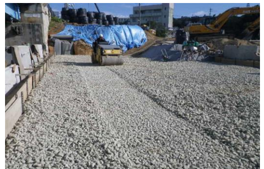
写真 - 2 盛土施工状況
