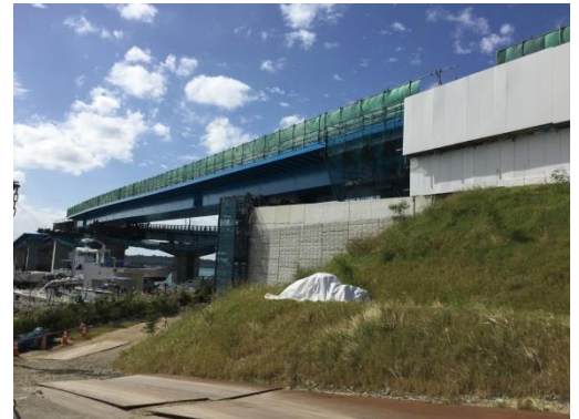
写真 - 1 桁の送り出し状況
