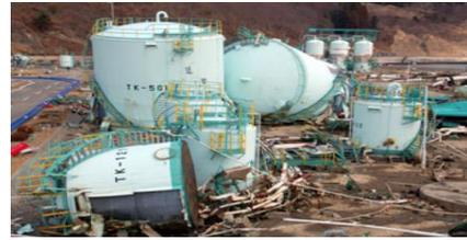
図-1 石油タンクの被害状況
