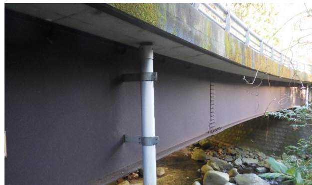
写真-1 YM橋全景
