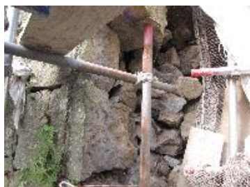
写真5 中詰め用ぐり石(立門橋)
