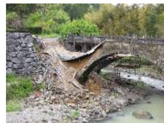
写真1 二俣福良橋の被害
