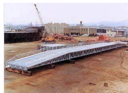
写真7 応急組立橋例
