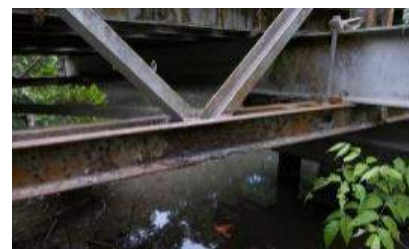
写真5 重度の腐食
