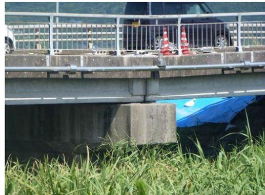
写真-2 中間橋脚の沈下現象
