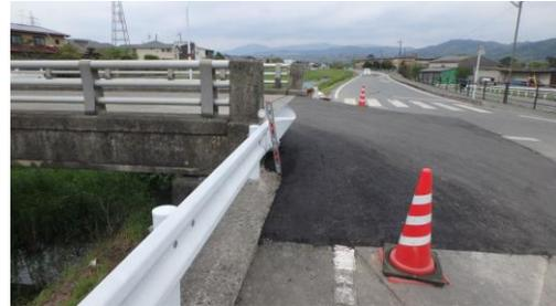
写真-1 橋台背面アプローチ部の沈下現象
