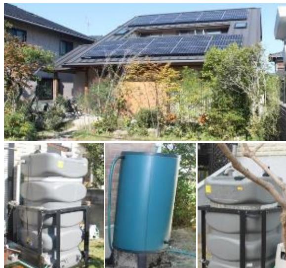
図 1 雨水利用実験住宅・1000ℓ・200ℓ・750ℓ タンク
