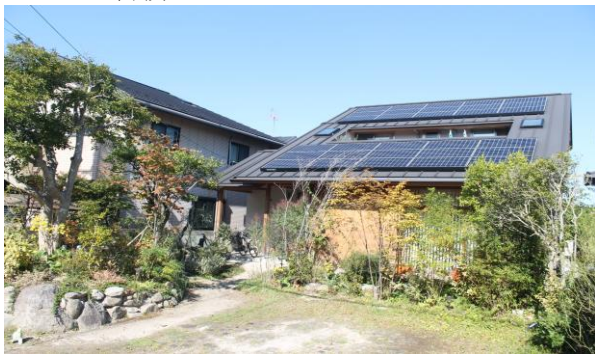
写真-1 雨水利用実験住宅外観
