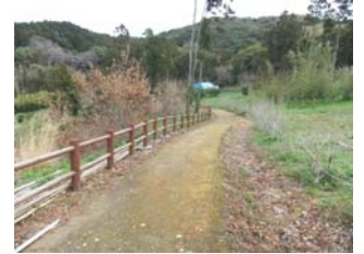
写真-1 施工2年半後の舗装体 表-1 まさ土の物理特性
