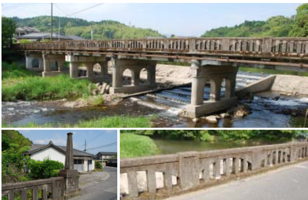
写真-1 山田橋の全景と親柱・高欄
