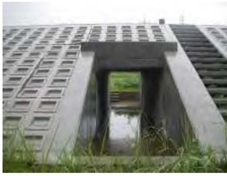
図2 研修用堤防の函渠
